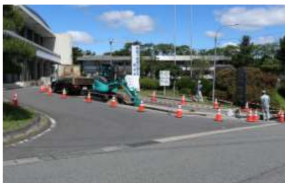
現在行われている下水道接続工事(入口付近)
